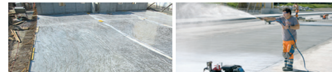
Recouvrement d'une dalle au moyen d'une feuille plastique.
