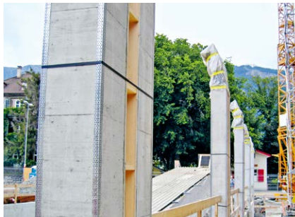
Figure 41 : Protection des arêtes (vives) d'un pilier
