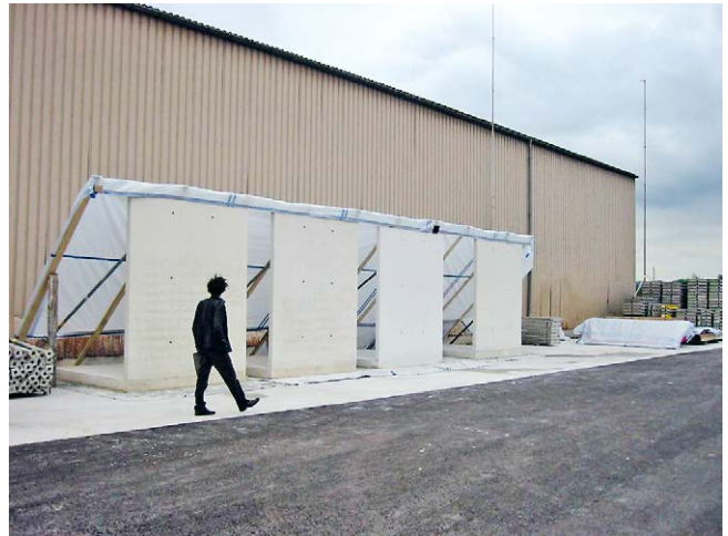
Figure 48 : Exemple de quatre surfaces d'essai (surfaces visibles) pour choisir le béton
