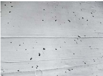
Fig. 21–24 : Surfaces de béton et surfaces de béton de parement, fabriquées avec des coffrages des types 1 à 4
