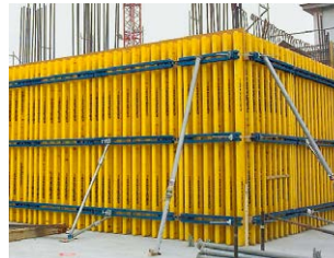
Coffrage panneaux avec poutrelles
