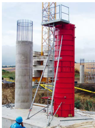
Coffrage d'une colonne
