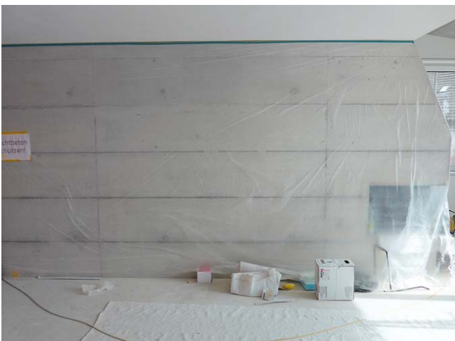
Figure 46 : Protection du béton de parement contre les salissures à l'aide d'une feuille plastique
