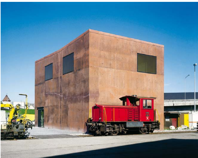
Figure 58 : Béton « rouillé » (Photo : poste d'aiguillage à l'entrée de la gare de Zurich Gigon/Guyer Architekten, Zurich)
