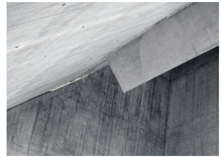
Figure 39 : Exemple de joints de peau de coffrage réguliers sur le plafond et la paroi ; bavures de mortier au joint de reprise entre ces deux éléments
