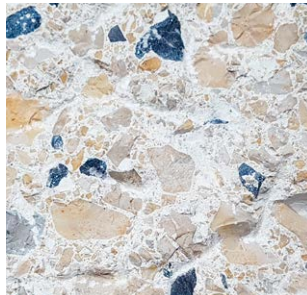
Piquetage (béton avec D max 16)
