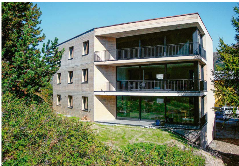
Figure 50 : Impression générale donnée par une habitation collective construite en béton de parement teinté dans la masse
