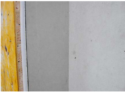
Figure 40 : Exemple de joint de reprise sur une paroi
