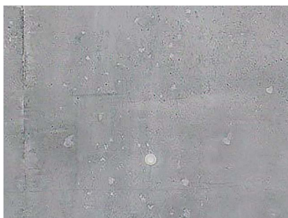
Figure 52 : Bullage mastiqué
