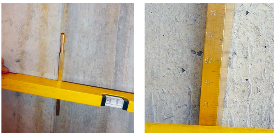
Figure 36 : Mesure de la planéité avec un coin de mesure ; valeurs mesurées d'env. 18 mm (à gauche) et d'env. 14 mm (à droite)
