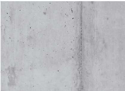
Figure 40 : Exemple de joint de reprise sur une paroi
