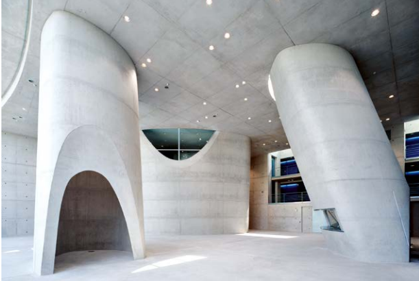
Figure 33 : Exemples de teinte relativement uniforme
