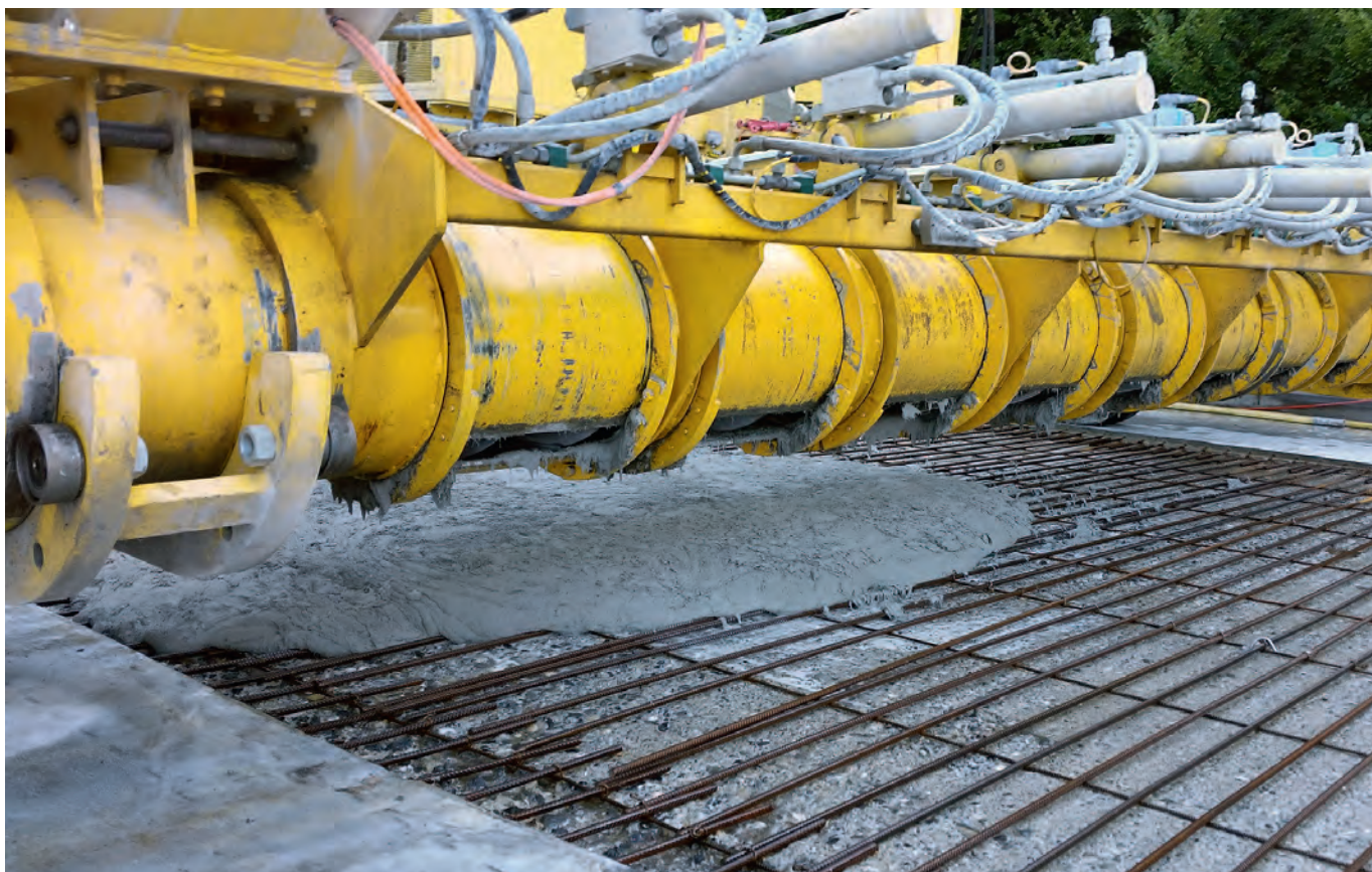
Posa a macchina di uno strato di rinforzo in Ductal® con finitrice (Viaducs de Chillon).
