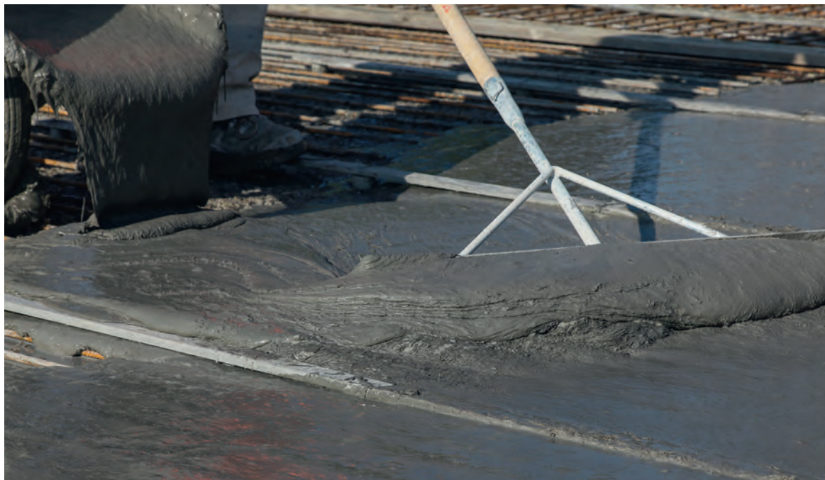
Il Ductal® ha una consistenza simile a quella del miele ed è molto viscoso.
