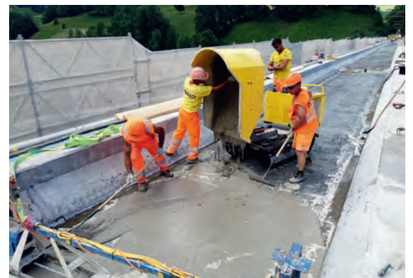
Applicazione dello strato di Ductal® sul fondo del trogolo.
