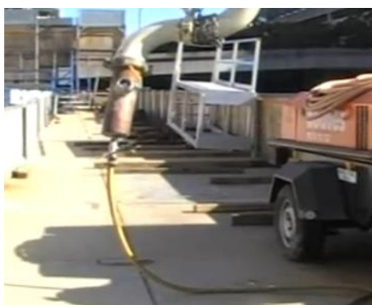
Nettoyage du pipeline à l'air comprimé
